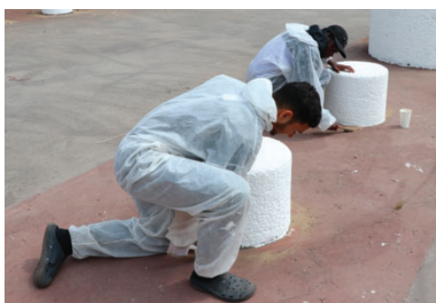
Dernières finitions autour des bacs
