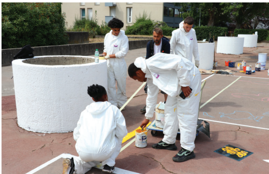
Après le nettoyage de la dalle, le marquage au sol peut commencer
