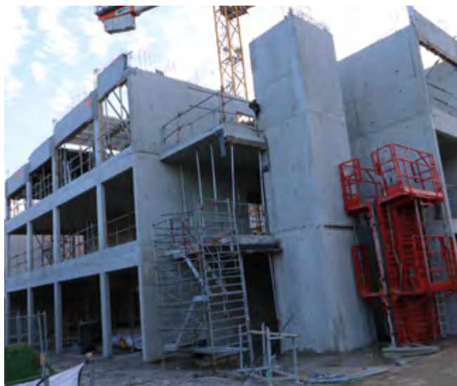
Le pôle petite enfance en construction.
