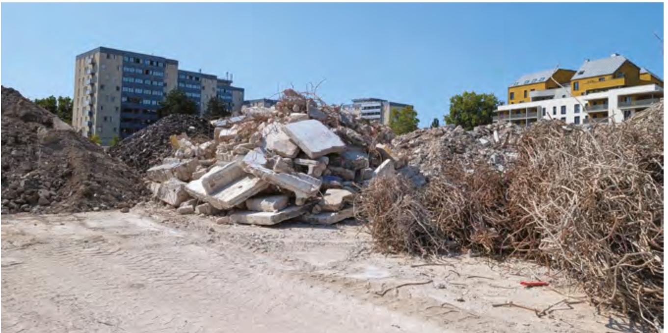
Les travaux de démolition sont à présent achevés. Les différents matériaux résultant de la destruction - béton, terre, feraille... - sont triés et conditionnés en vue de leur recyclage. Une bonne partie d'entre eux sera utilisée sur place, notamment pour le remblayage du terrain.
