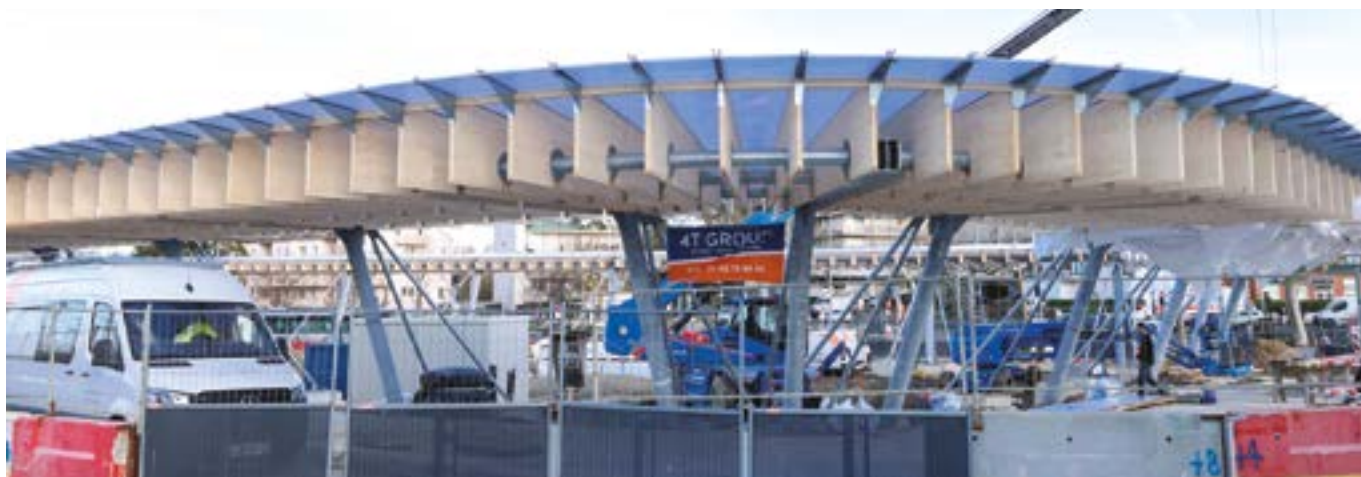
13 > Retour sur les travaux
